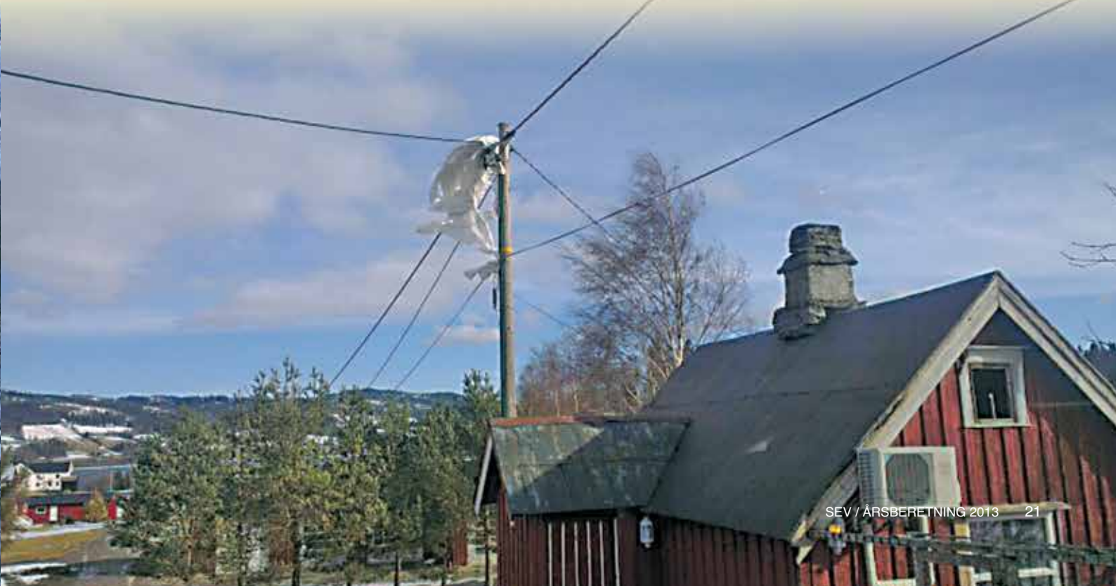
Godt det bare var plasten og ikke hele rundballen som havnet i stolpen.
