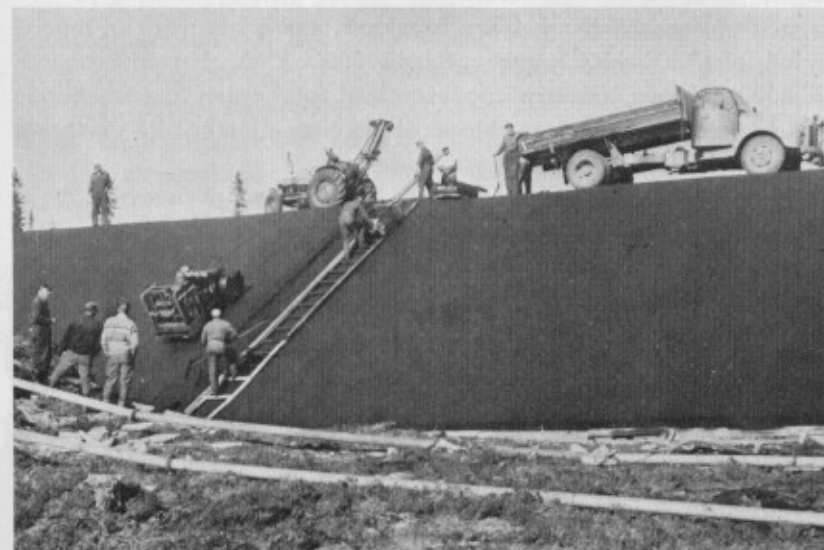
Asfaltering av Julskardammen
